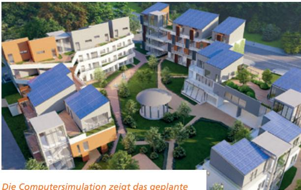
Die Computersimulation zeigt das geplante Quartier Landwehrviertel in Osnabrück mit Solardächern und einem Erdsondenfeld zur Wärmeversorgung.
