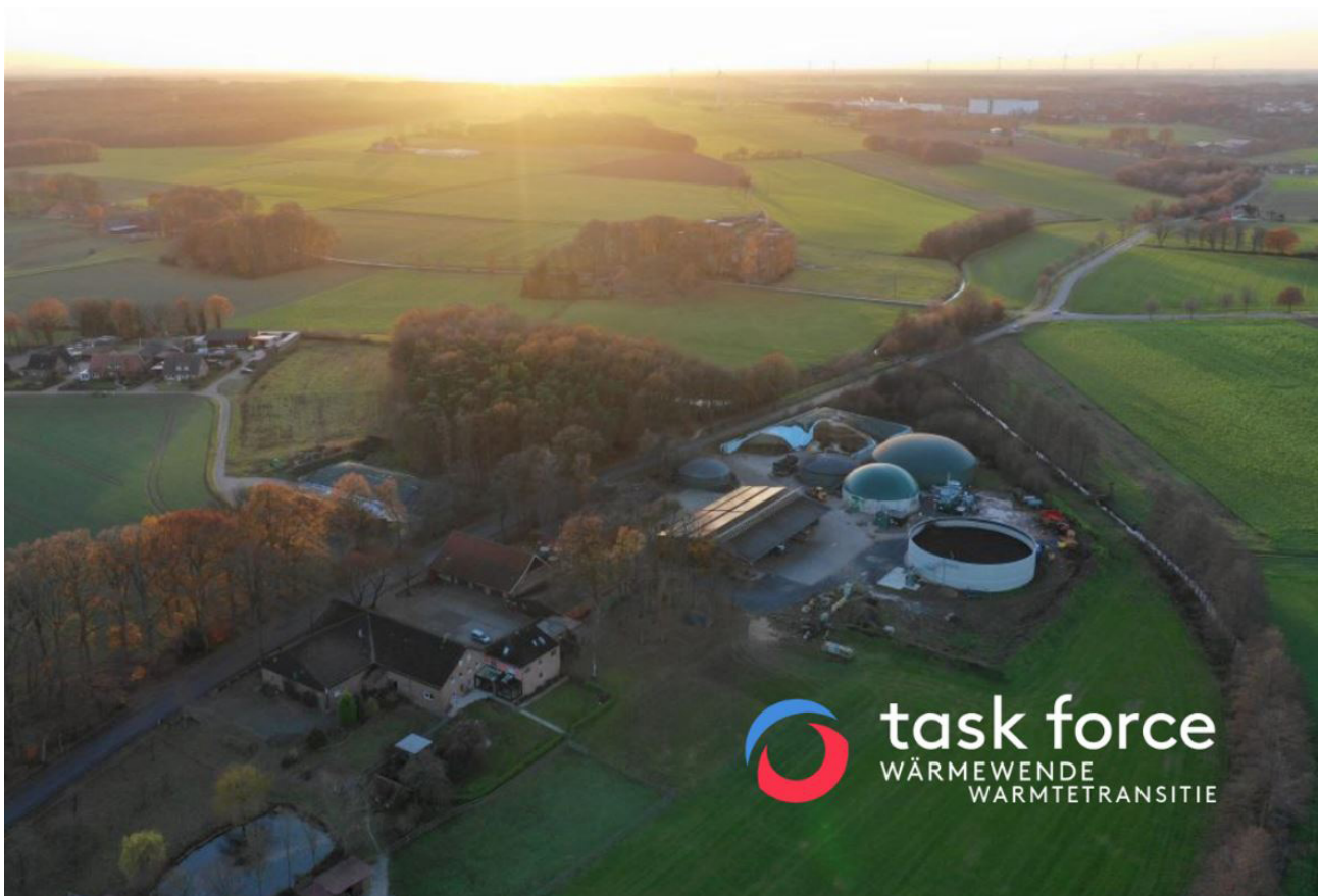
Die Biogasanlage Benning mit Blick auf Bahnhof Reken // Foto: Benning Agrar-Energie GmbH
