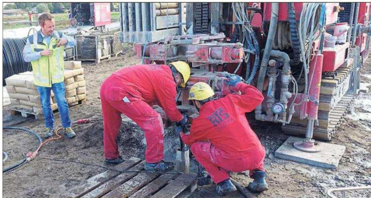
Projektleiter Tobias Ahlers von den Stadtwerken Warendorf im Gespräch mit Mitarbeitern der Fachfirma, die zurzeit Tiefenbohrungen im neuen Baugebiet „In de Brinke“ durchführt. Die Nahwärmeversorgung gilt als Leuchtturmprojekt und wurde mit öffentlichen Fördermitteln bedacht. Foto: Stadt Warendorf
