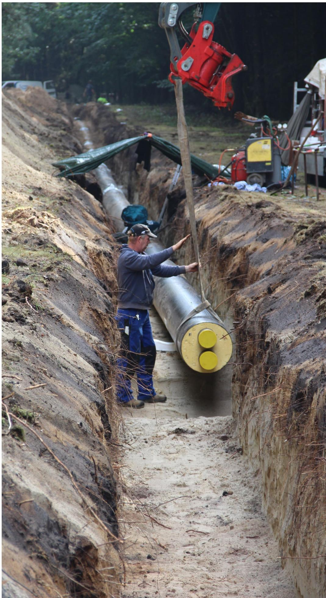
Eines nach dem anderen werden die 16 Meter langen und 750 Kilogramm schweren Leitungselemente in die Erde gebracht.
