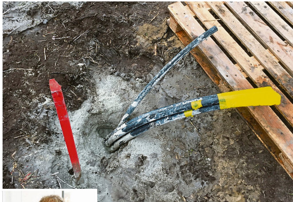
Oben schaut noch ein guter Meter Rohr aus dem verfüllten Sondenloch. Im Betrieb sieht man über der Erde davon nichts mehr, erklärt Florian Skirde (kl. Bild).
